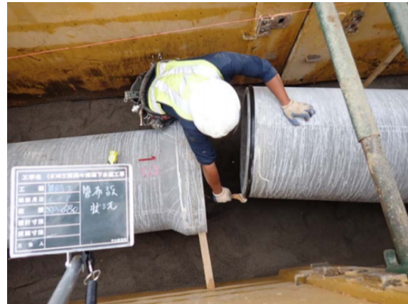
（参考写真）雨水管敷設状況
