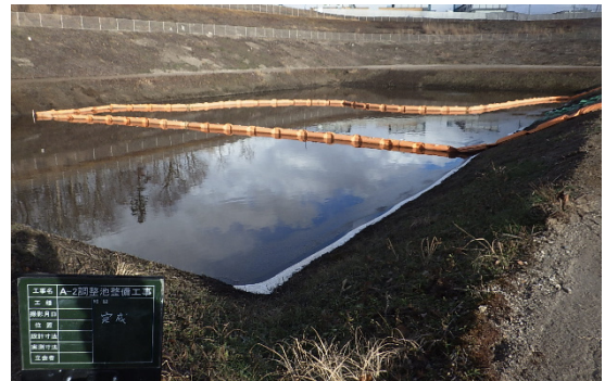
（参考写真）沈砂池
