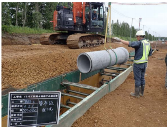
（参考写真）雨水管敷設状況
